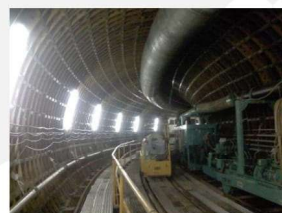
トンネル坑内
