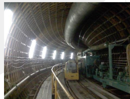
トンネル坑内
