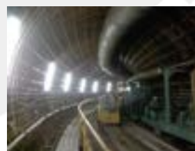
トンネル坑内
